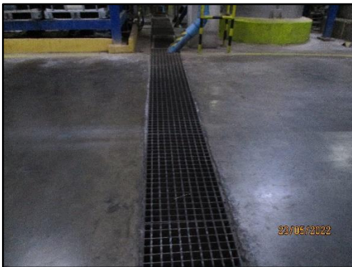
ภาพที่ 2.23 รางระบายน้ำเสียภายในพื้นที่โครงการ
